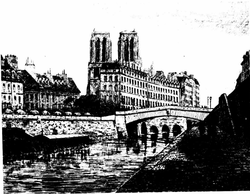
Befestigtes Seineufer mit Blick auf das hôtel-Dieu
