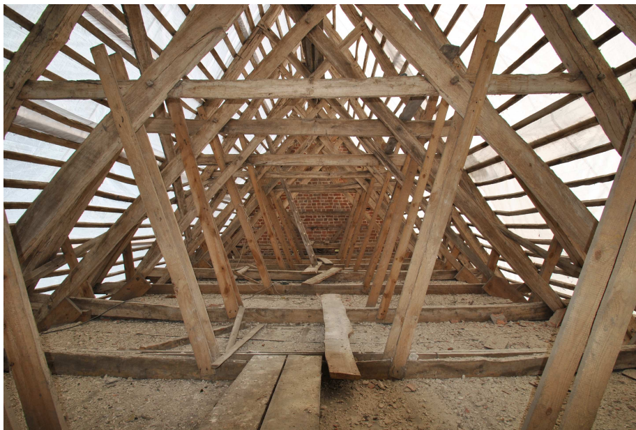
Abb. 1 Quitzow, Dorfkirche, Chor, Dachkonstruktion von 1292 (d) S
