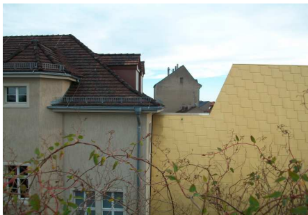
Luckenwalde: Bibliothek im Bahnhof Anfügung der modernen Kinder- und Jugendbibliothek an das denkmalgeschützte Bahnhofsgebäude und Auswirkungen auf die Dachlandschaft der Stadt
