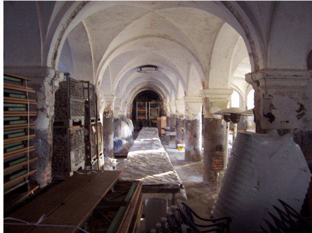
Kreuzgratgewölbe eines Stallgebäudes
