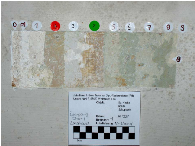
Abbildung 1: Beispiel für einen Sondierungsschnitt, Farbschichtentreppe. Objekt: EKD Evangelische Kirche in Schubach (Hessen). Ausführung: 07 / 2007.
