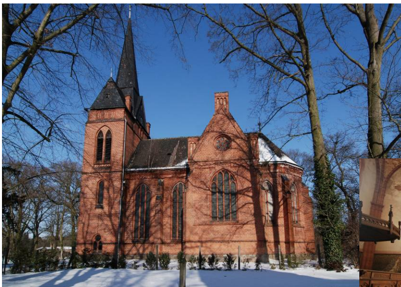
Außen- und Innenansicht der Schönfelder Kirche.
