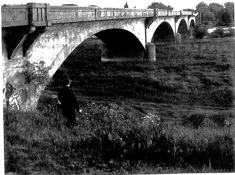
Unüberbrückbare Brücke: sie endet mitten in der Oder ...
