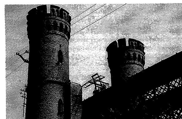
Bild 6. Alte Dirschauer Weichselbrücke: Teil eines Überbaus mit zwei Pfeilertürmen; auf dem Überbau ist zwischen den Türmen der erhaltene Besichtigungswagen zu erkennen (eigene Aufnahme)
