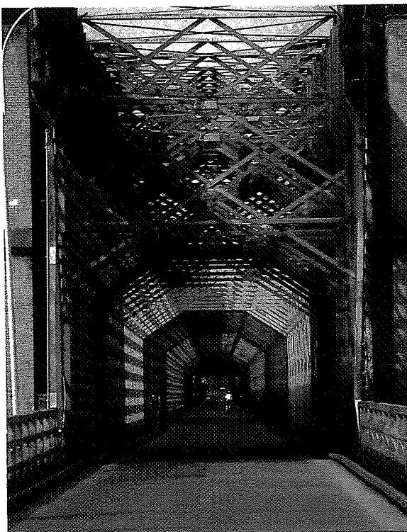
Bild 5. Alte Dirschauer Weichselbrücke: Blick in das Innere der erhaltenen Überbauten von der Bruchstelle am östlichen Ende aus; deutlich zu erkennen ist die Struktur der oberen Querverbände (eigene Aufnahme)
