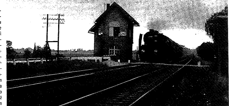
Modernizacja magistrali polegała m.in. na budowie posterunków odstępowych (blokowych). Niektóre z tych obiektów zachowały się do dziś i służą jako stażnice przejazdowe; szlak Stare Biełkie - Krzyż, P47-120, 1.07.1985 r. Fot. P. Terczyński
